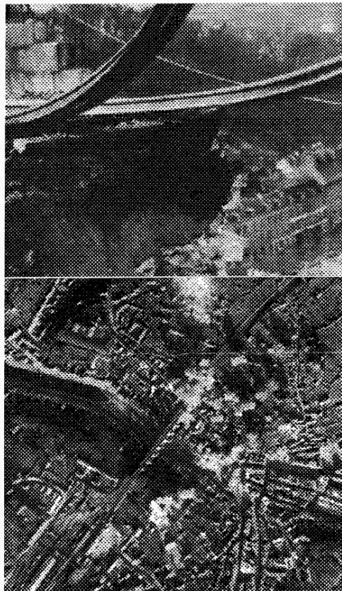
Bombes sur le viaduc photo aérienne du bombardement de Morlaix
