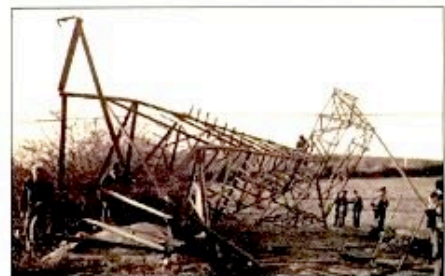
Destruction d'un pylône à haute-tension dans l'Allier.
