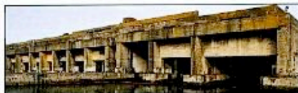
La base sous-marine de La Pallice.
