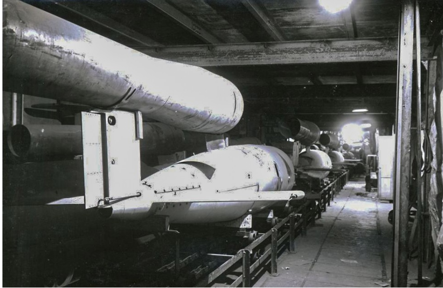
Assemblage de V1 dans un tunnel de Mittelbau
