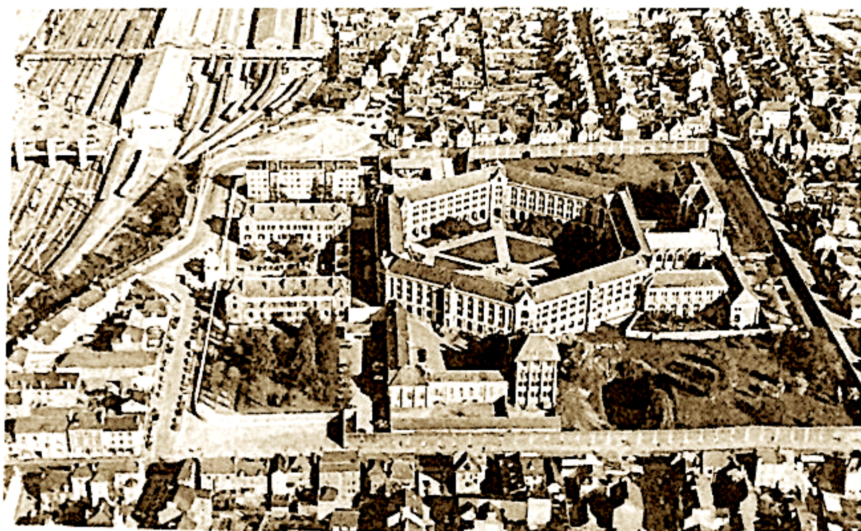
Vue de la centrale de Rennes, prise dans les années 1970. © Archives départementales d'Ille-et-Vilaine, 5699W
