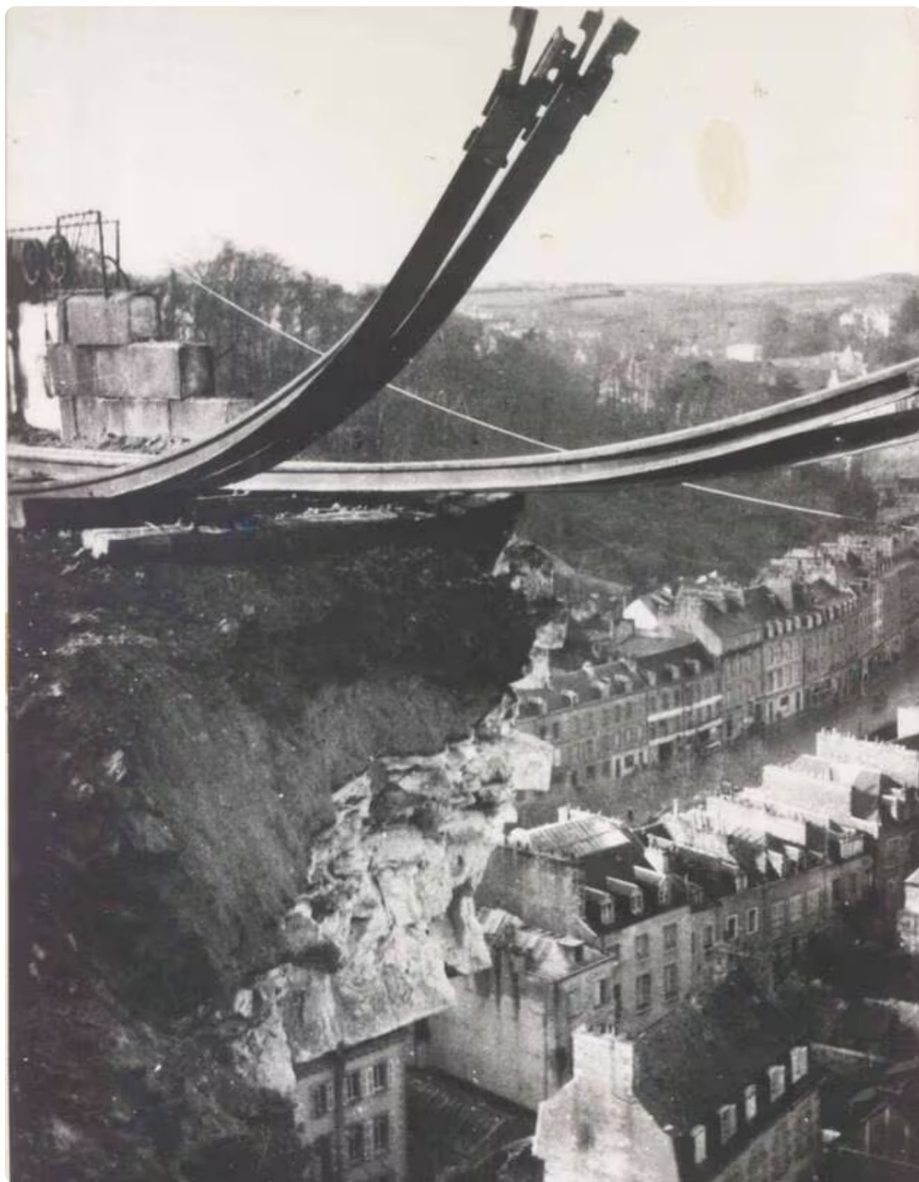
Les rails sectionnés du viaduc de Morlaix après le bombardement du 29 janvier 1943. Photo prise par un soldat allemand. | ARCHIVES OUEST FRANCE
