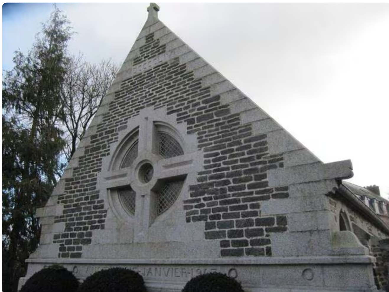
Erigée en 1954, la chapelle Notre-Dame-des-Anges rappelle la tragédie qui a coûté la vie à 39 enfants de l'ancienne école voisine et de leur institutrice lors du bombardement du 29 janvier 1943. | OUEST-FRANCE
