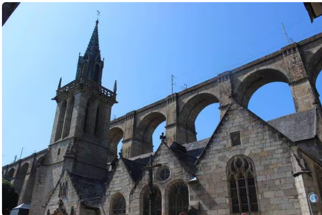
L'église Saint-Melaine avait été endommagée. Une bombe avait détruit la sacristie, le bas-côté gauche de l'église et avait abîmé le presbytère. | OUEST FRANCE
