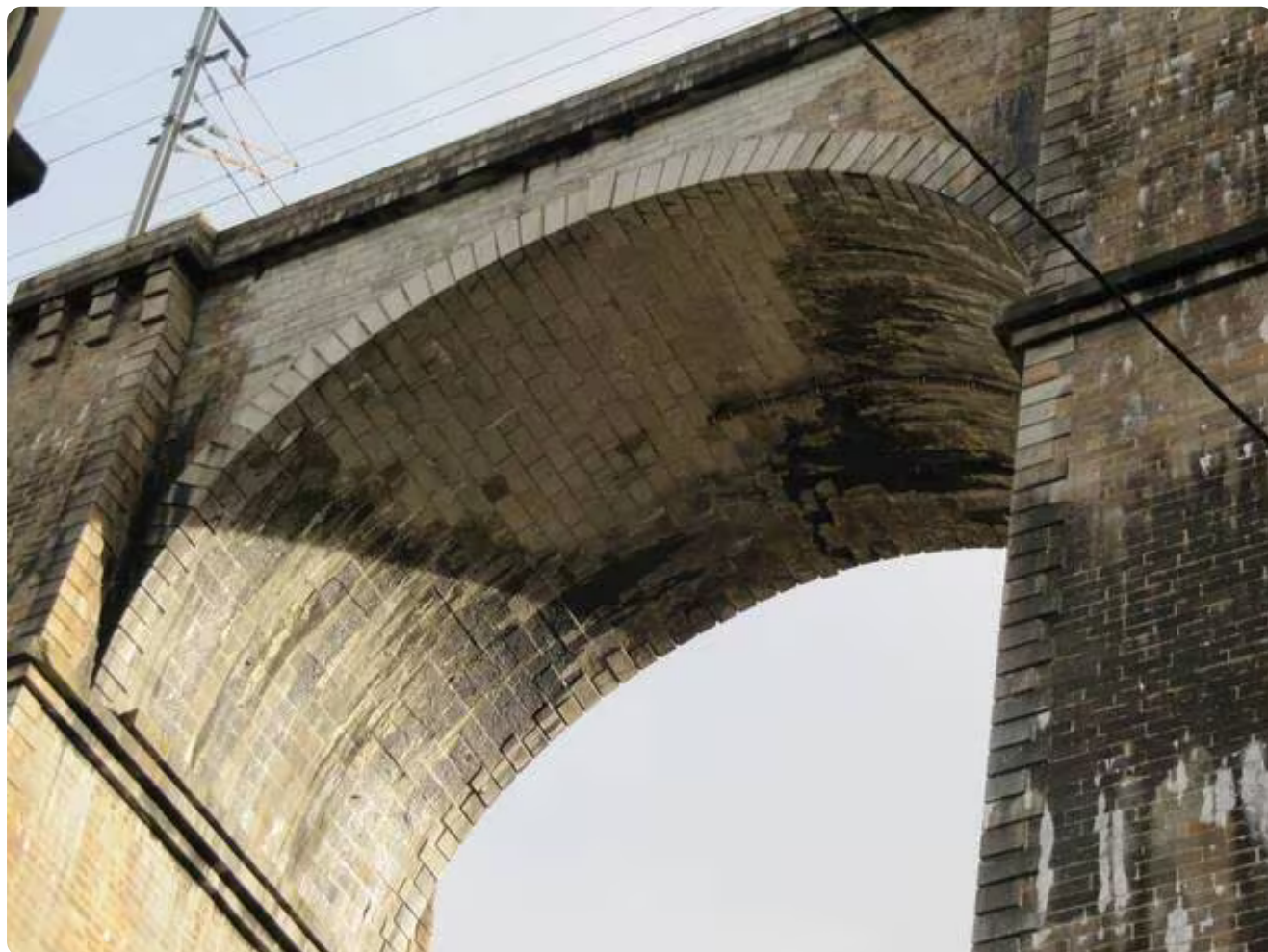
Une arche du viaduc porte toujours l'empreinte du bombardement de 1943 qui l'avait détruite aux deux tiers. | OUEST-FRANCE
