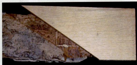
5) Collage et ajustage du doublage en chêne. Puis comblement des manques avec un mélange de poudre de bois et d'acétate de polyvinyle (VR 200 diluée à 50%).
