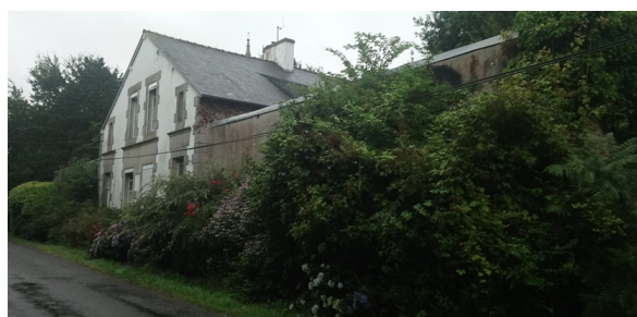
École de Église Blanche, commune de Bannalec. Changement de destination du bâtiment en maison.
