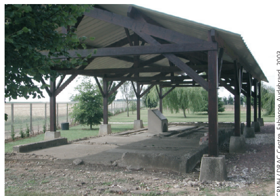
Fondations de la baraque des bains-douches.
