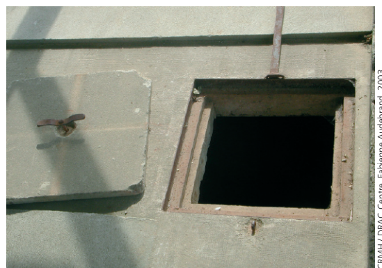
Entrée du tunnel d'évasion.
