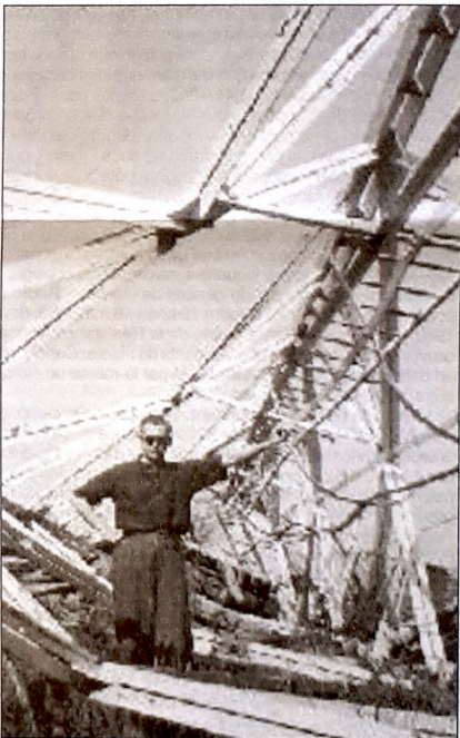
Pylône de l'émetteur d'Allois détruit en mai 1942
