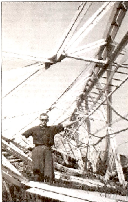
Pylône de l'émetteur d'Allouis détruit en mai 1942
