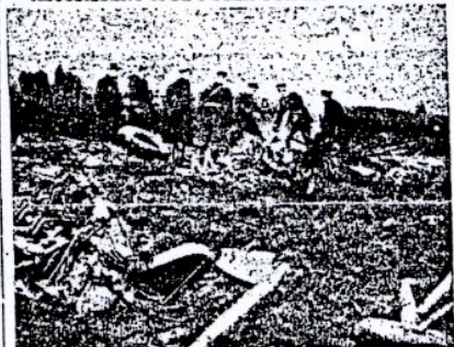
Les débris de l'appareil, qui a percuté et pris feu.
