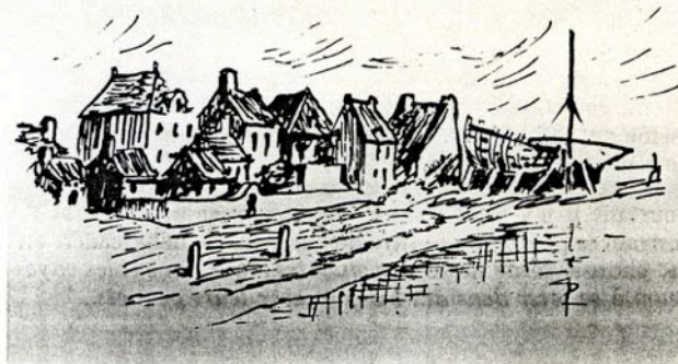
MÉAN : les chantiers de la marine en bois.
