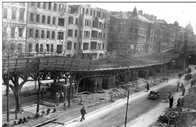
Le réseau aérien est lui aussi très endommagé.
