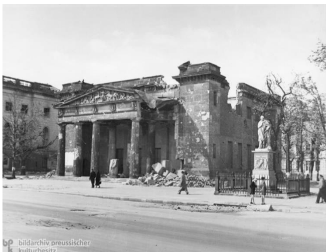
Le bâtiment à l'abandon, peut-être vers 1949, porte toujours les stigmates de la guerre.
