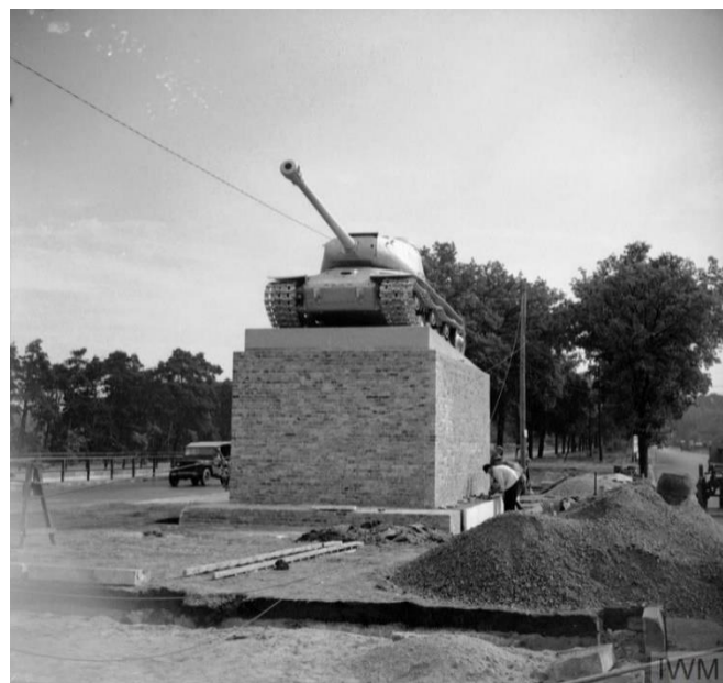
Derniers travaux avant l'inauguration.
