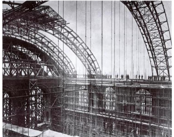
Construction de la gare : mise en place de la structure métallique de la verrière.
