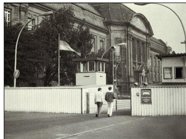
Poste de passage à Invalidenstrasse .
