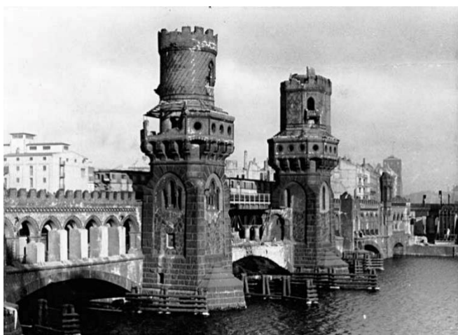
1950, les tours sans les toits, détruits par sécurité.
