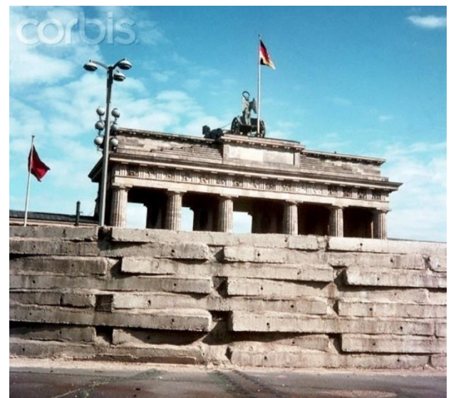
Plus tard le mur sera enduit et parfaitement lisse.
