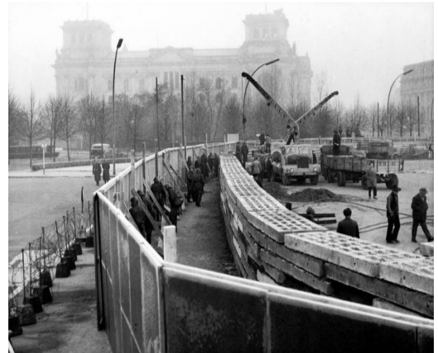
Renforcement du mur. Photo prise à l'Ouest.
