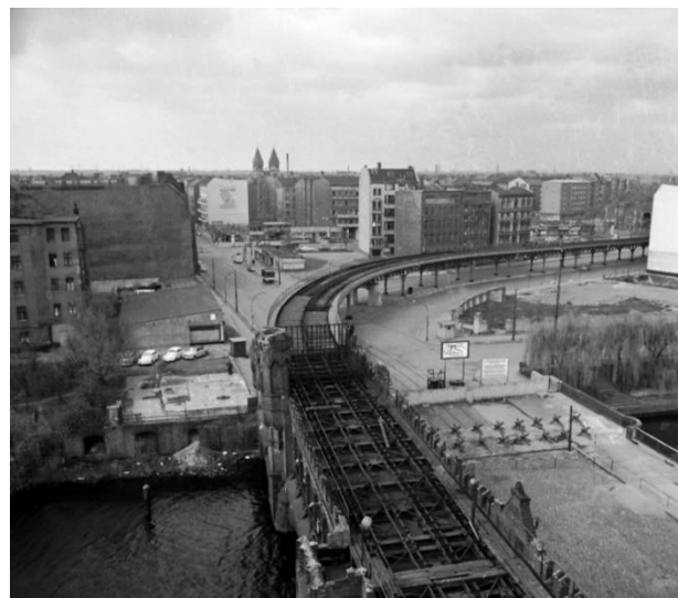
La ligne de métro est aussi coupée, les rails démontés. Une haute palissade coupe la voie.
