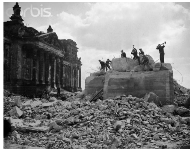
Destruction des bunkers devant le Reichstag .
