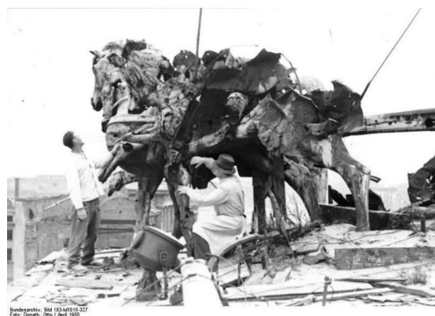
1950, premiers travaux de consolidation.
