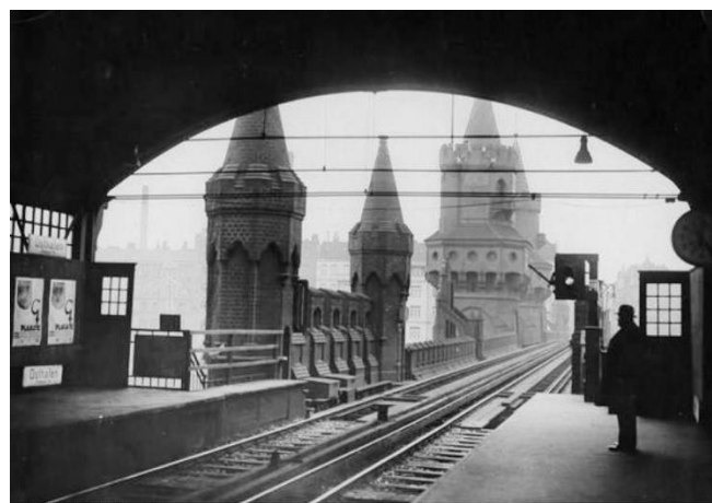
Vue du pont depuis la station de métro.
