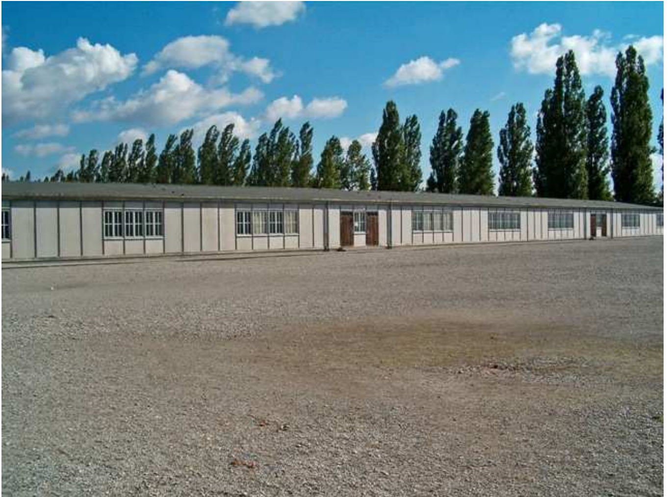
Vue extérieure de l'une des baraques
