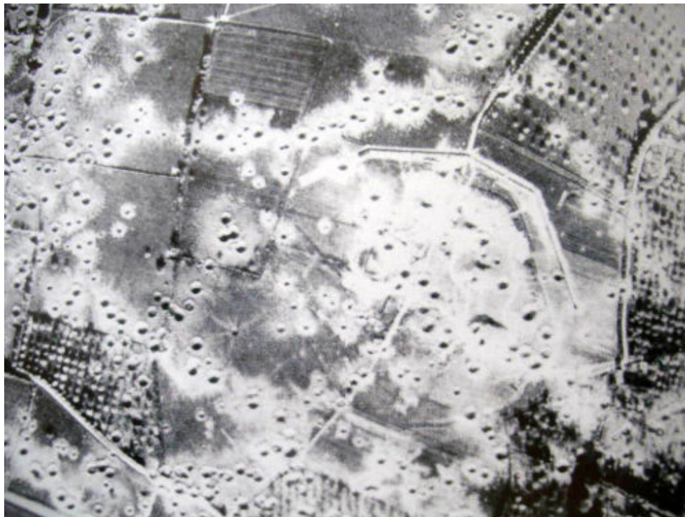
Fig. 2 : Photo de la batterie après un bombardement
