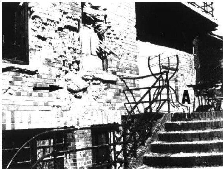
La façade arrière de la maison. La flèche indique l'impact de l'obus. La famille était réfugiée dans la cave sous le repère "A" (Photo Jean Jacob)
