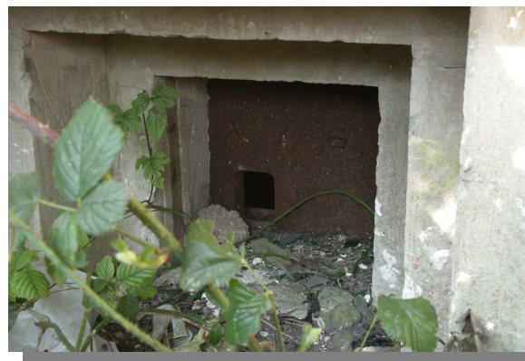
Caponnière avec sa plaque blindée
