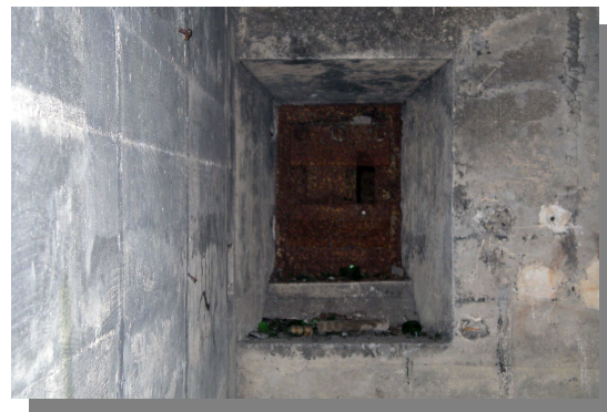
Créneau de défense de l'entrée (vue de l'extérieur)
