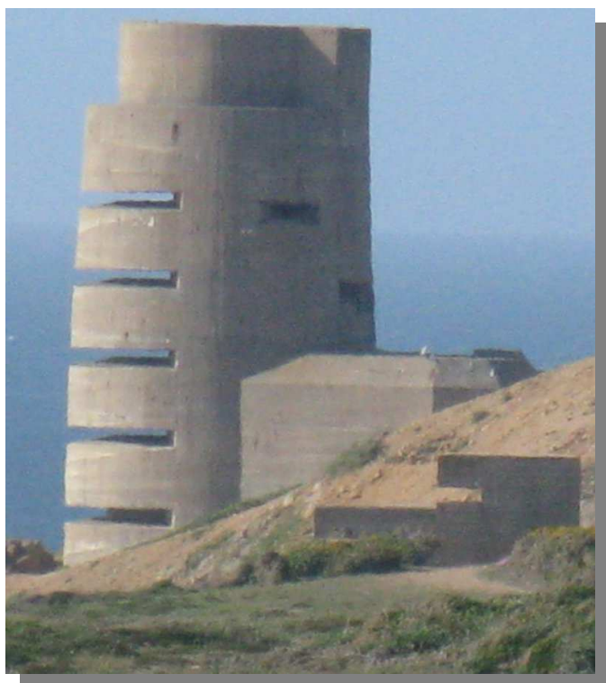
Tour d'observation MP3 de la batterie Moltke
