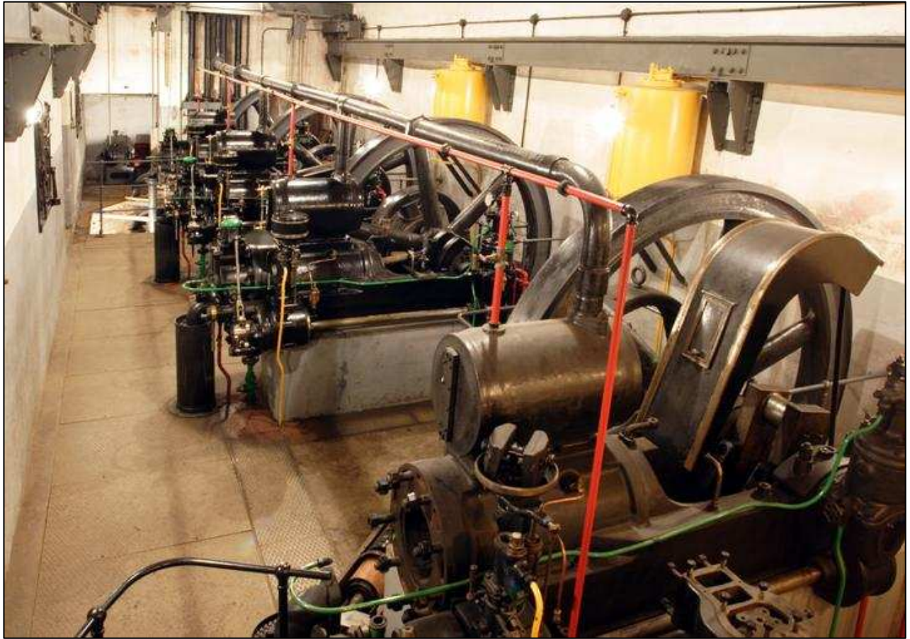
Salle des machines, vue d'ensemble
