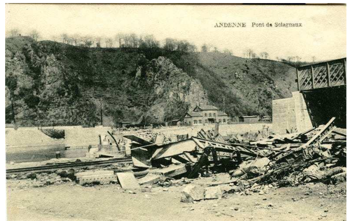
Le pont d'Andenne détruit
