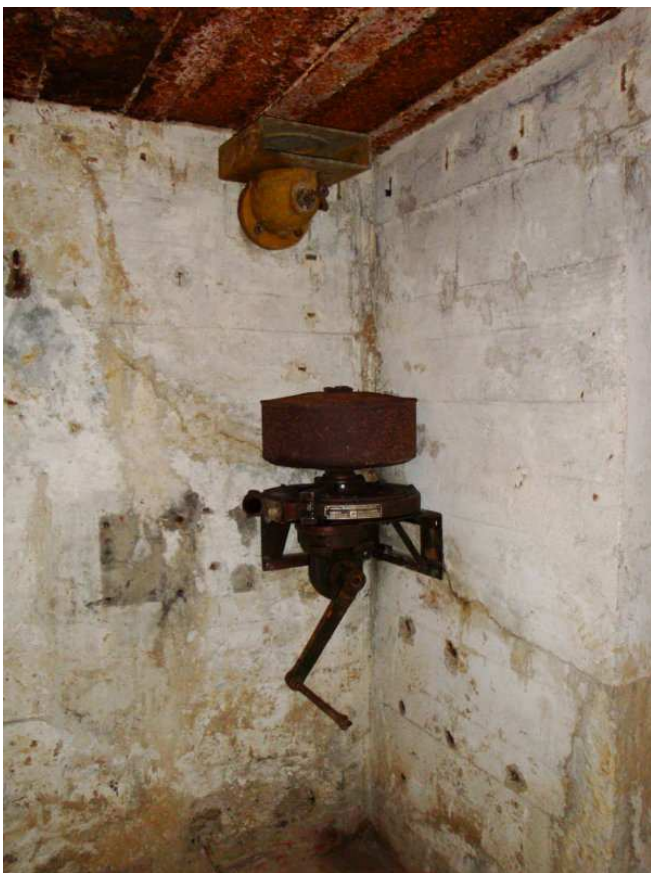
Ventilateur anti gaz (filtres manquants)
