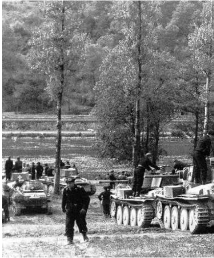
Les Pz 38 (t) (Panzer 38 tonnes) doivent attendre que le génie ait fabriqué des ponts suffisamment solides pour leur permettre le franchissement de la Meuse.
