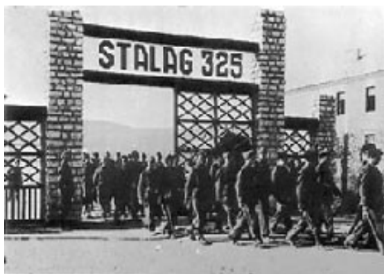
Entrée du camp de Rawa-Ruska
