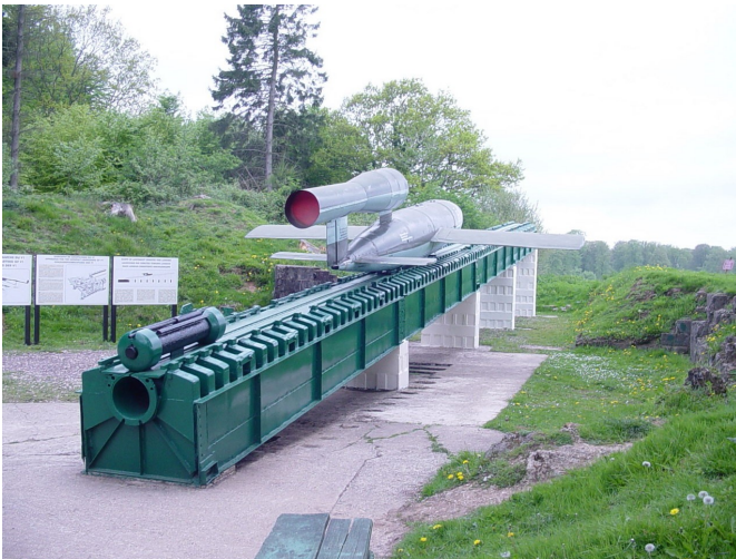
Rampe de lancement d'un V1 restaurée en forêt d'Ardouval
