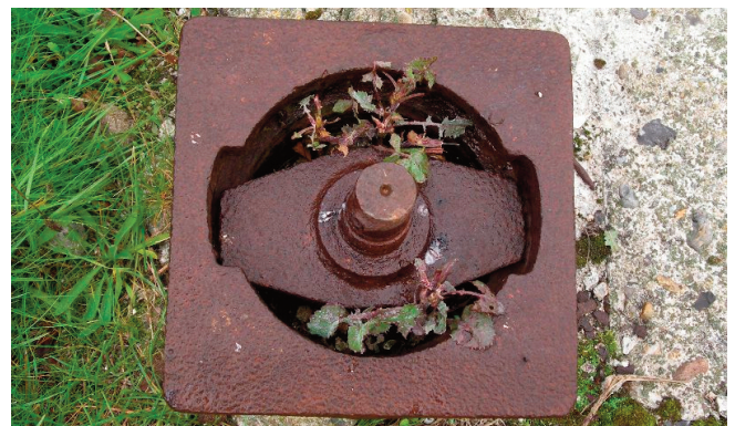
Obturateur de périscopes (côté intérieur). La poignée est manquante.
