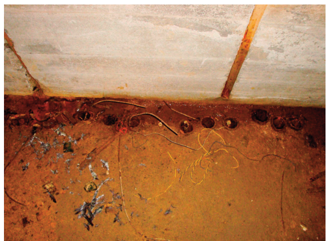
Vestiges de gaines électriques dans la salle de transmission au sous-sol
