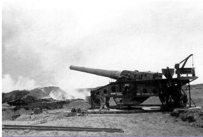
Tir d'un canon de 340 de la batterie du Bégot
