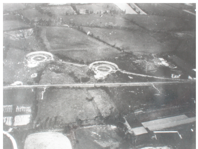
Vue aérienne de la batterie
