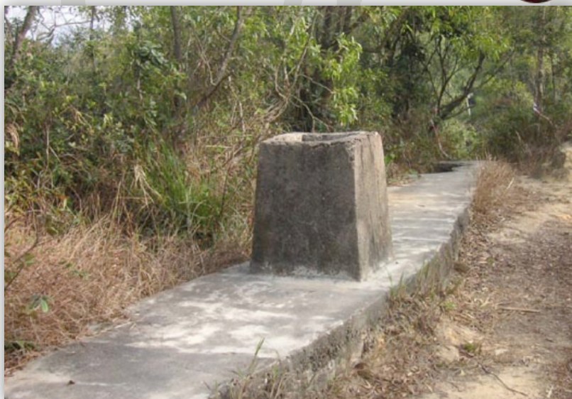
Cheminée de ventilation des tunnels
