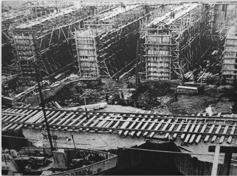
Construction de la base. Au premier plan des caissons remplis de sable isolent le chantier d'élévation des murs des futures alvéoles. (Photo Bundesarchiv)
