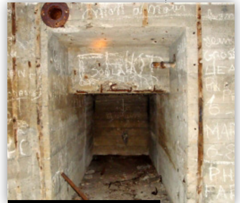
Miche pour citerne d'eau potable (chambre officier)
