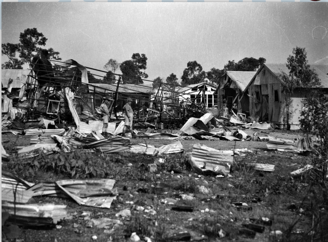
Dégâts provoqués par le bombardement à Darwin
