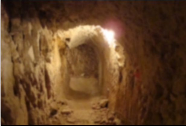
Galerie d'accès à la salle du canon avant travaux
