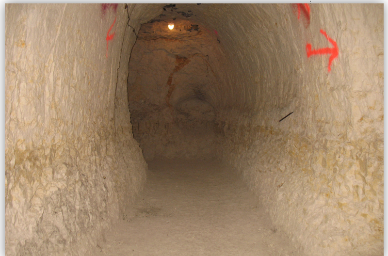
Galerie accès à la salle du canon après déblayage et aménagement
