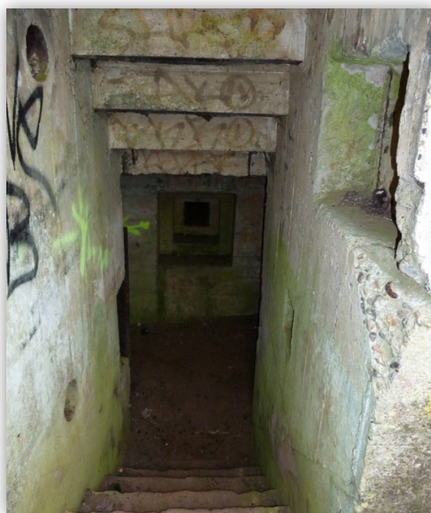
Escalier avec en bas le créneau de défense intérieur
