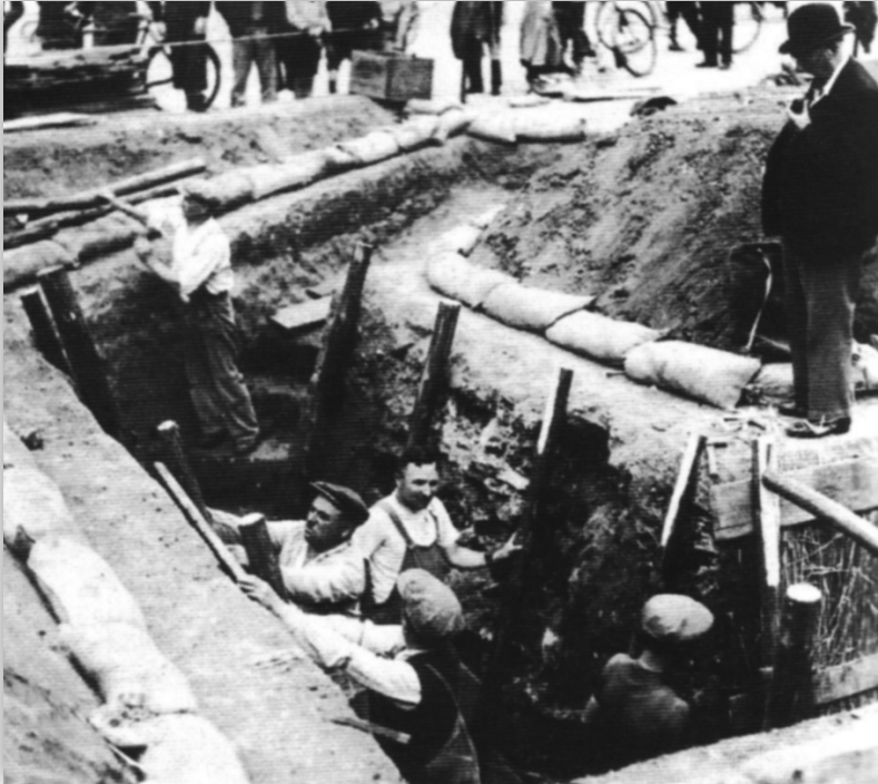
Creusement d'un abri à ciel ouvert.
