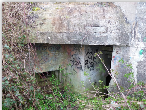
Entrée du blockhaus avec la caponnière
