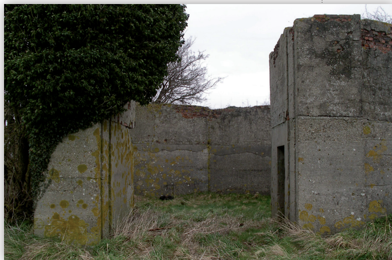
Cuve pour radar Freya
