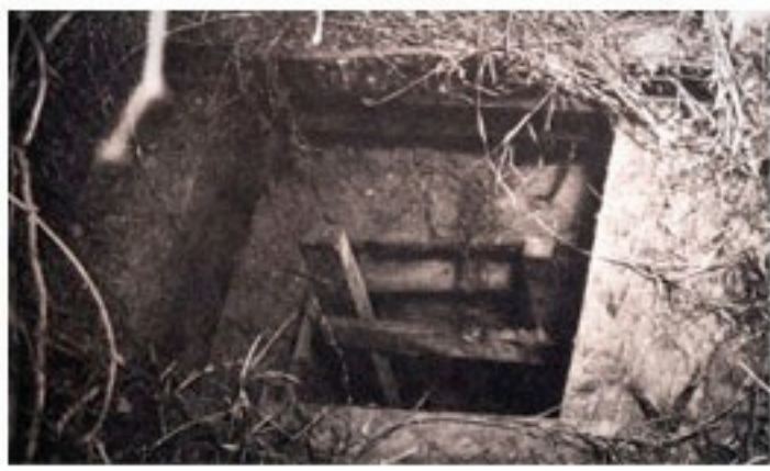
Entrée du Tunnel
