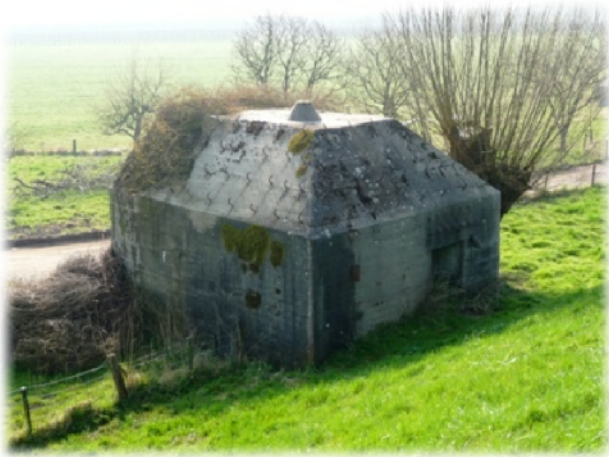
ABRI "PYRAMIDE" AVEC SUR LE TOIT LA SORTIE DU PÉRISCOPE
