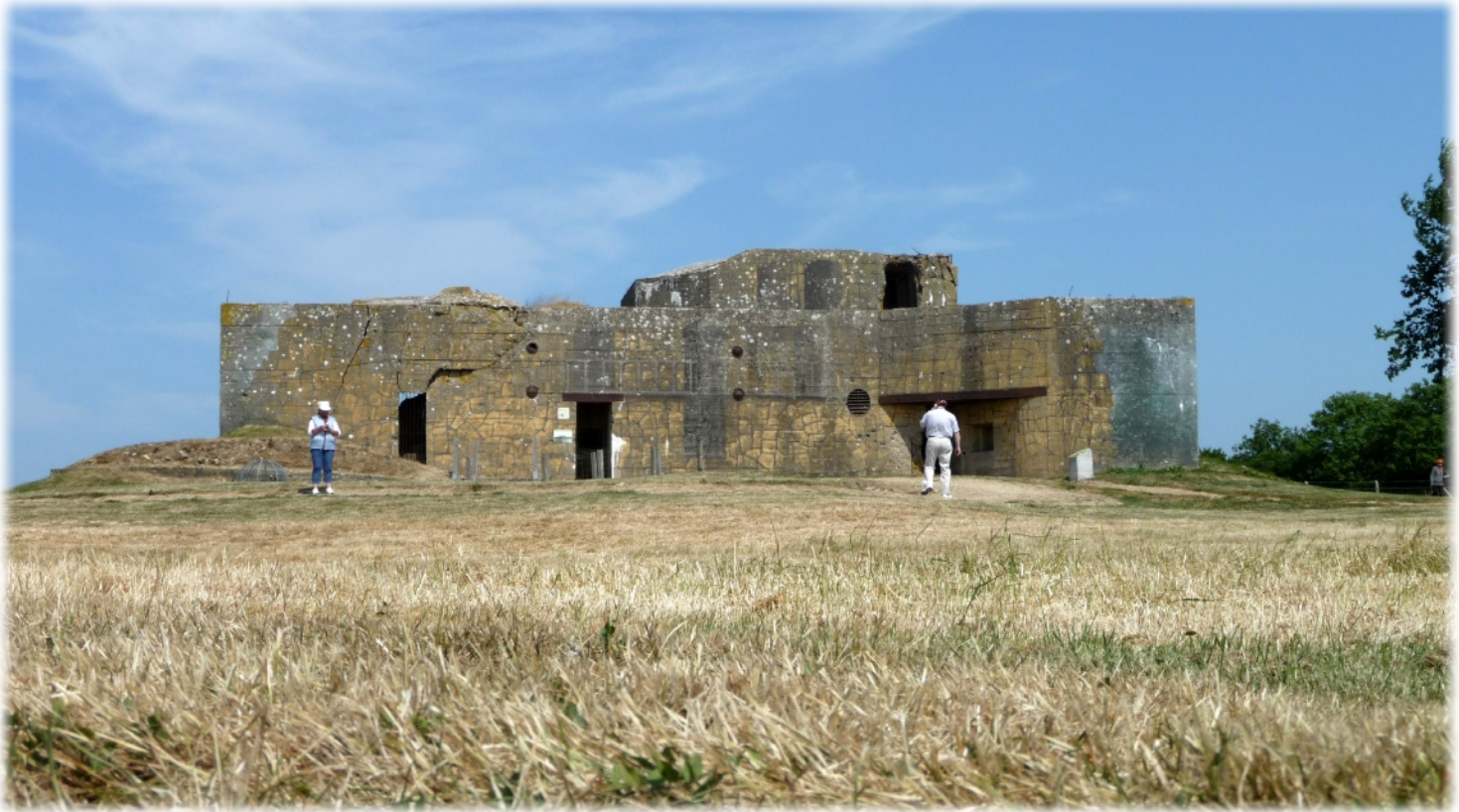
R650 DE LA BATTERIE D'AZEVILLE
