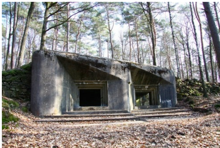
CASEMATE D'ARTILLERIE WINDSTEIN
