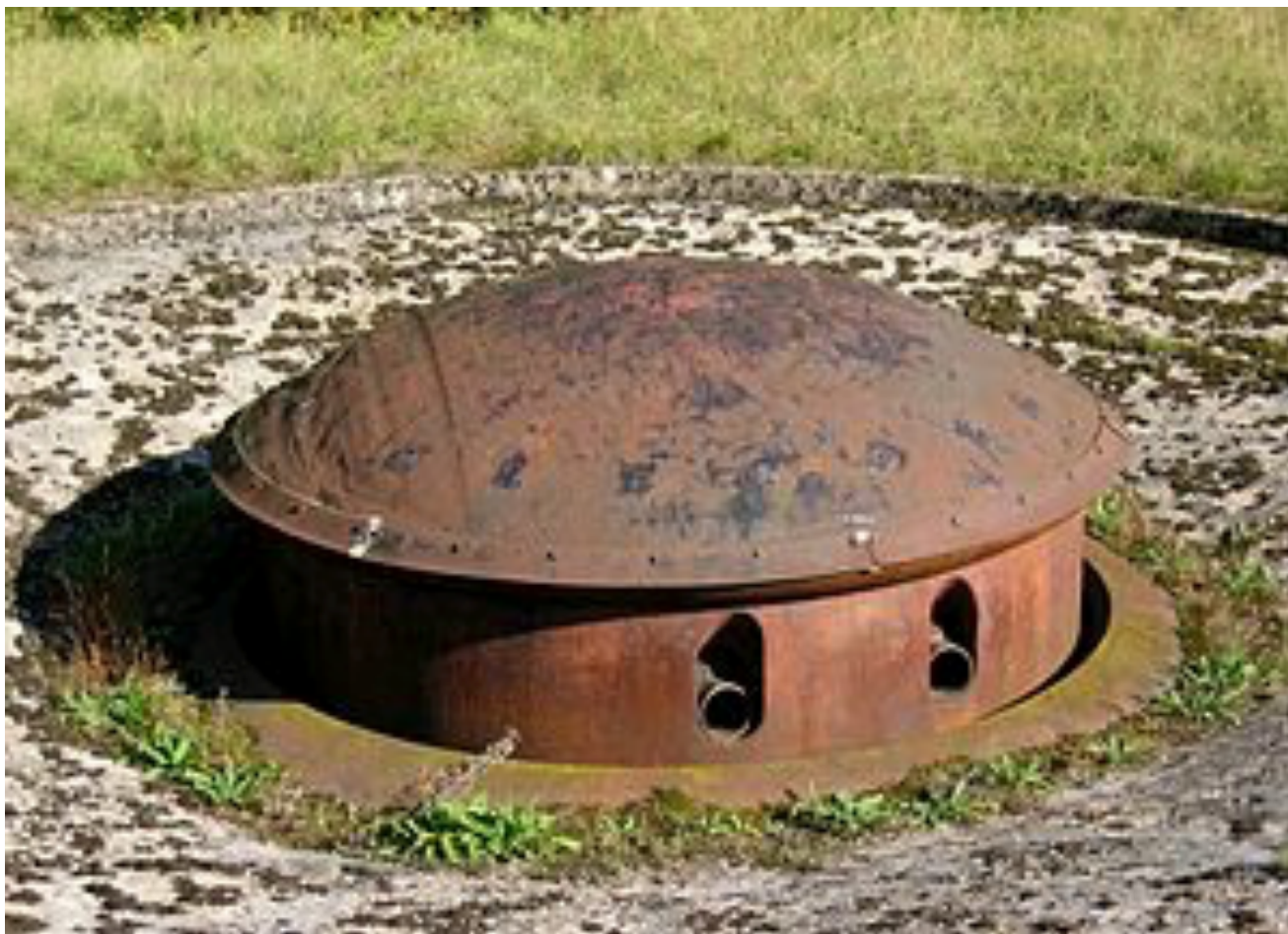
TOURELLE ÉCLIPSABLE POUR LANCE BOMBES DE 135MM
