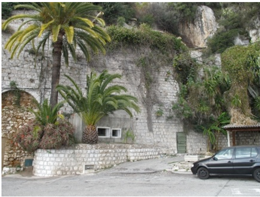
OUVRAGE DU PONT SAINT-LOUIS
