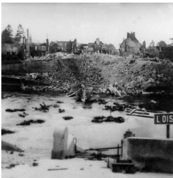
PONT DE L'OISE DÉTRUIT À CREIL. (DR)
