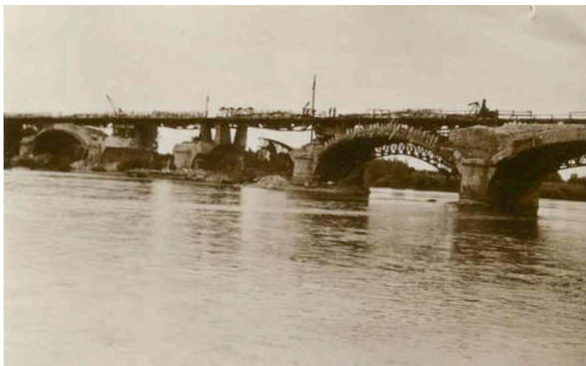
LE PONT DE PORT BOULET APRÈS LE BOMBARDEMENT DES ARTILLERS FRANÇAIS
