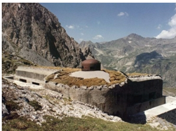
L'OUVRAGE DU PAS DU ROC (SCE : WWW.FORTWEB.NET )
