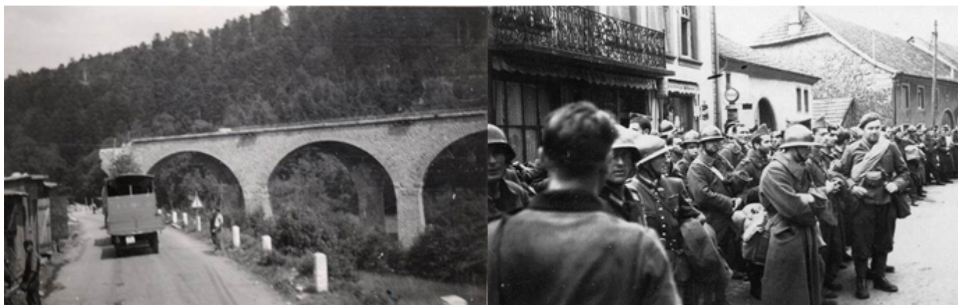
LE VIADUC FERROVIAIRE DE FOUDAY, DÉTRUIT LORS DU REPLI FRANÇAIS. PRISONNIERS À ST BLAISE LA ROCHE.
