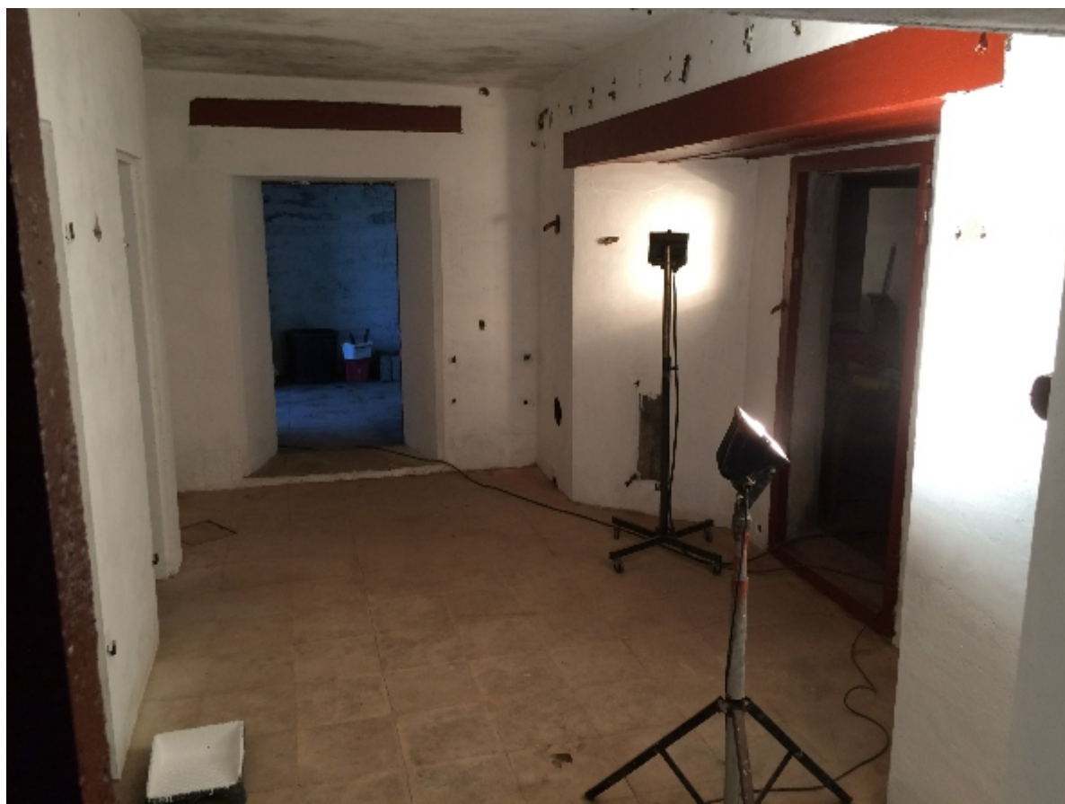
INTÉRIEUR DE L'ABRI HÔPITAL R638, FUTUR SIÈGE DE L'ASSOCIATION (NOTEZ LES PANS COUPÉS DE TOUS LES ANGLES AFIN DE FACILITER LA MANUTENTION DES BRANCARDS. NDLR)
