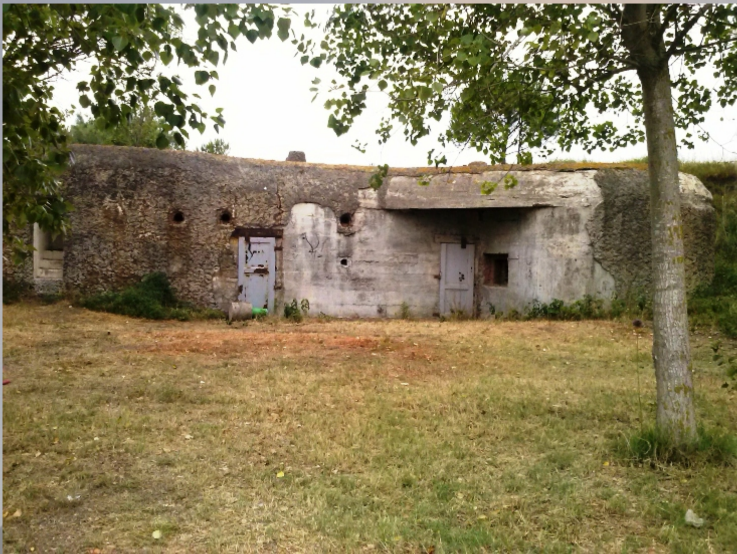
R610 DE LA TAMA SUR LE CAMPING DU MÊME NOM
