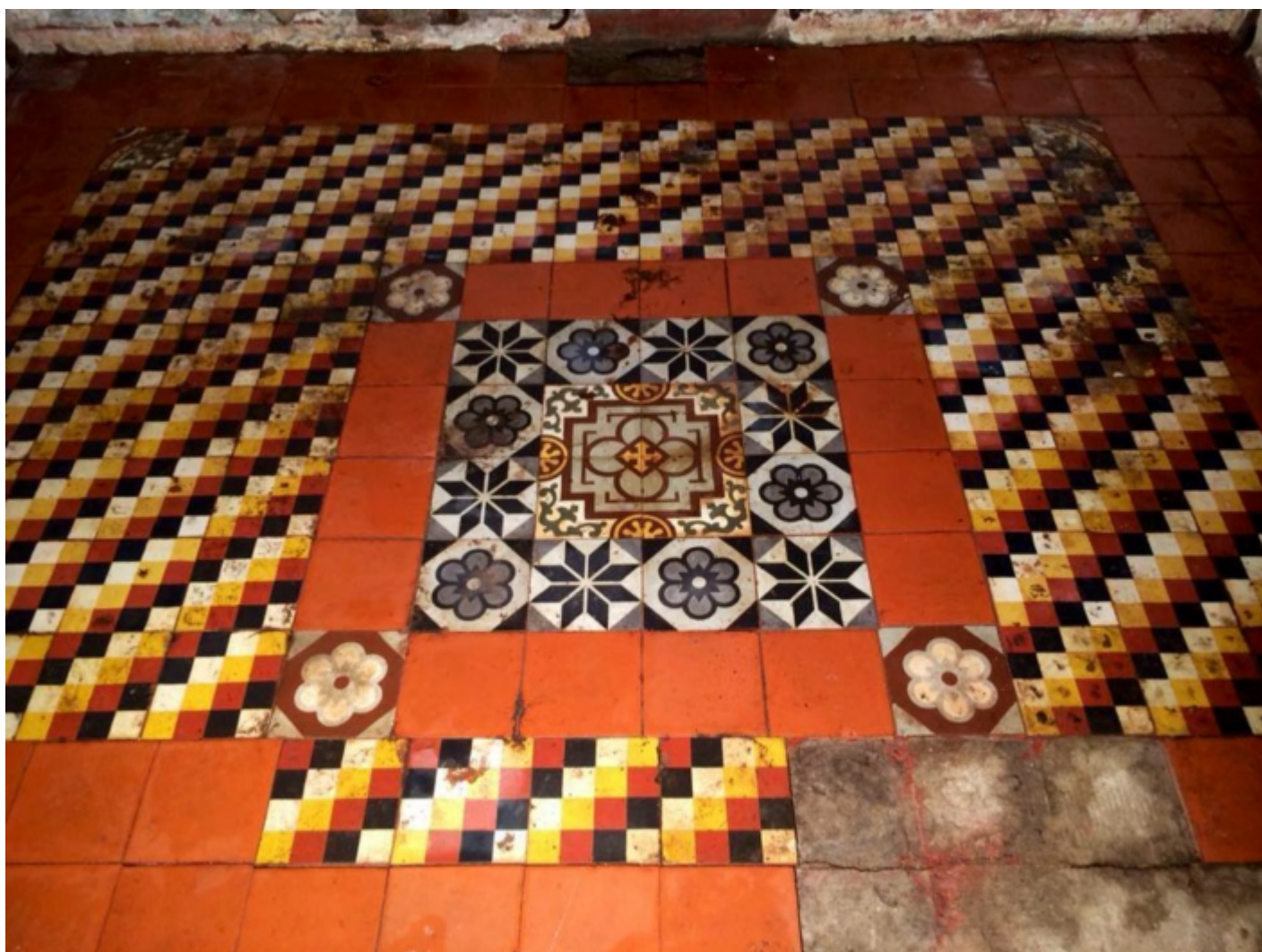
ÉTAT DU SOL APRES LA RESTAURATION...
