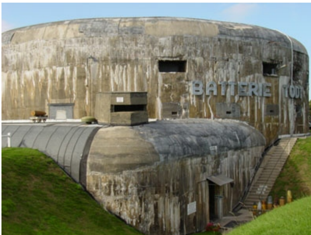
TURM 1 (NOTER LES OUVERTURES DU BAS MURÉES)
