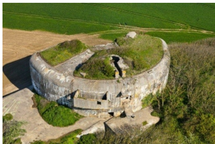
TURM 4 (NOTER SUR LE TOIT UN ENCUVEMENT POUR FLAK ET AU SECOND PLAN UN POSTE POUR MG)
