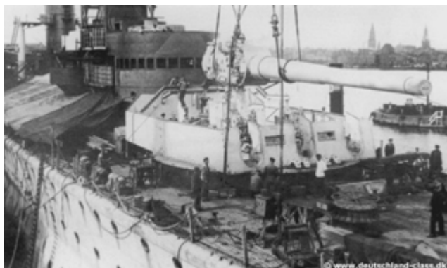
LA POSE DES CANONS DE 28 CM DANS LES TOURELLES TRIPLES AUX CHANTIERS DE KIEL
