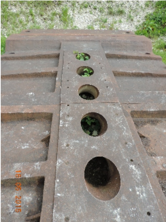
BLINDAGE DES BOUCHES DE SORTIES DES TUBES À MIMOYECQUES (POIDS 53 T.)
