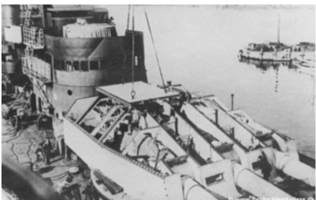
LES CANONS DE 28 CM POSÉS, CE SONT LES PLAQUES DE BLINDAGE DES TOURELLES TRIPLES QUI SONT INSTALLÉES
