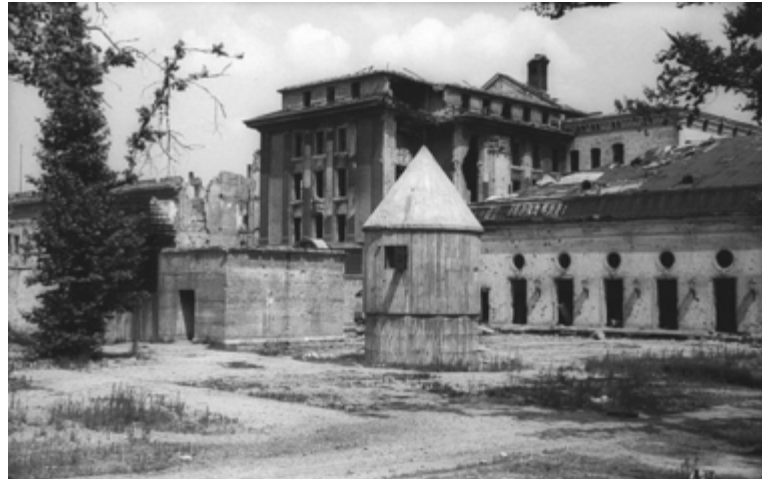
1946. TOUR DE GARDE ET ENTRÉE DU BUNKER (AU FOND LA SALLE DE BAL)
