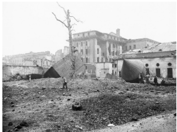
L'ENTRÉE DU BUNKER EN 1948 APRÈS LA DESTRUCTION DES OUVRAGES DE SURFACE
