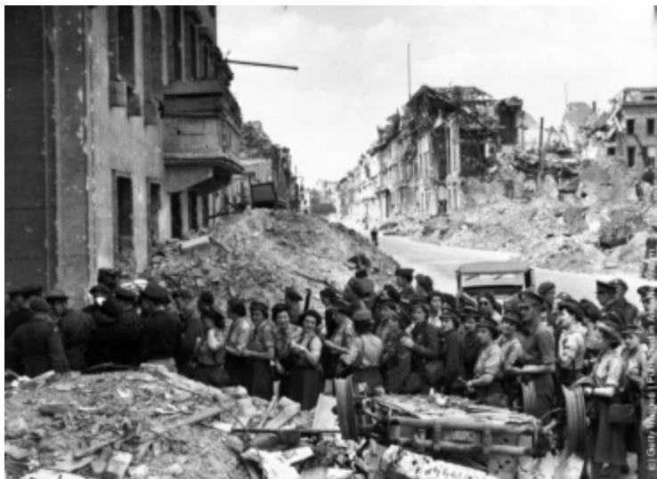
BERLIN, JUILLET 1945. LES VISITEURS SE PRESSENT À LA PETITE ENTRÉE DE LA CHACELLERIE
