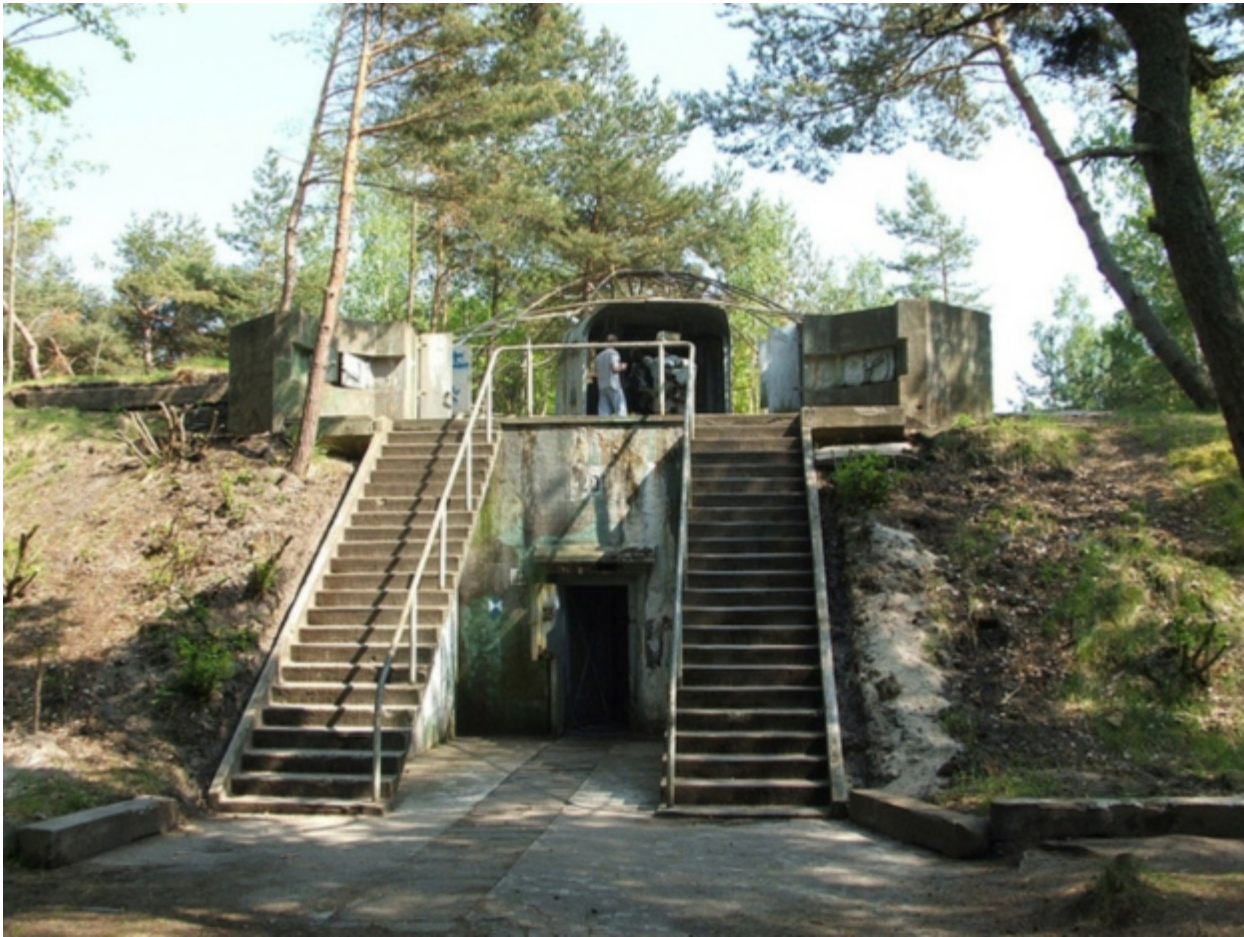
BLOCKHAUS POUR CANON DE 152 AVEC SON ENCUVEMENT AU-DESSUS
