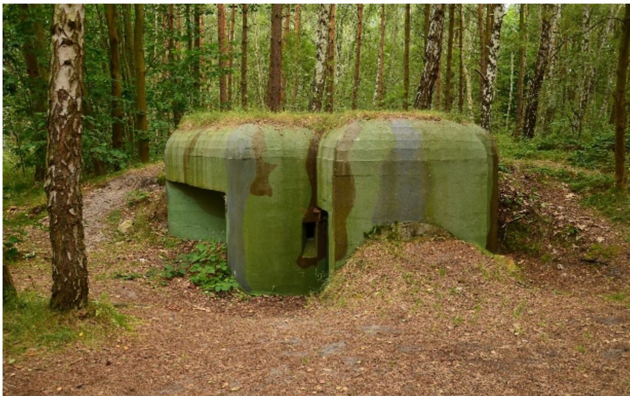
PETIT BLOCKHAUS POUR MG AVEC À GAUCHE L'EMBRASURE ET AU CENTRE LA GOULOTTE LANCE GRENADES PROTÉGEANT L'ENTRÉE
