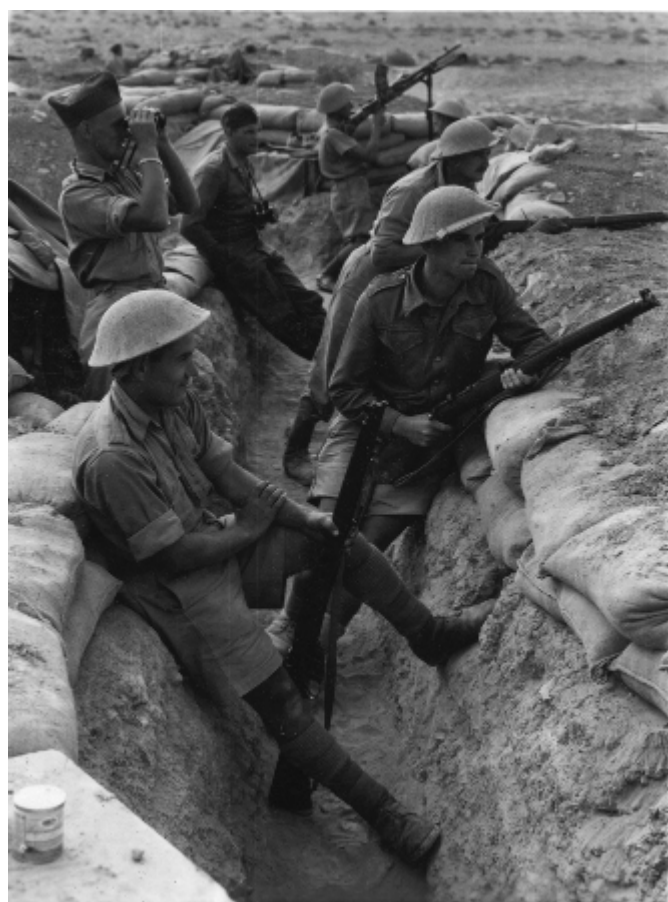
TRANCHÉE TENUE PAR LES POLONAIS DE LA BRIGADE INDÉPENDANTE DE CHASSEURS DES CARPATHES À TOBROUK EN 1941.
