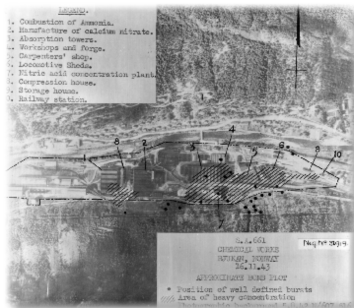
ANALYSE DE PHOTOGRAPHIE AÉRIENNE PRISE APRÈS LE BOMBARDEMENT DU 16 NOVEMBRE 1943
