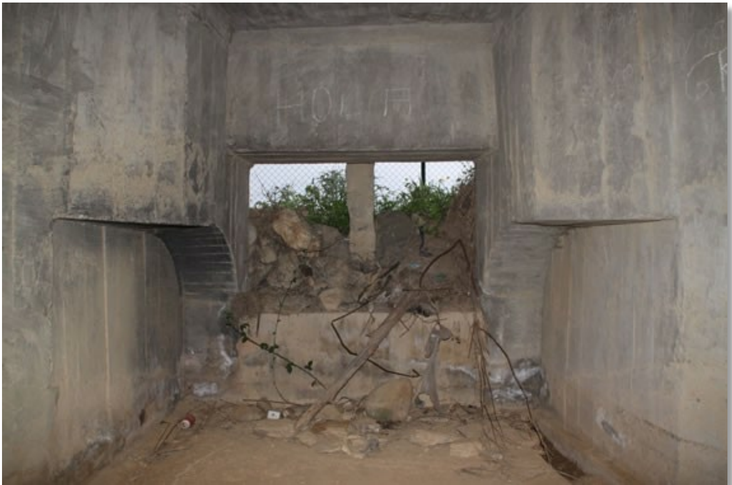
BLOCKHAUS POUR CANON ANTICHAR (NOTER L'EMPLACEMENT DES ROUES)
