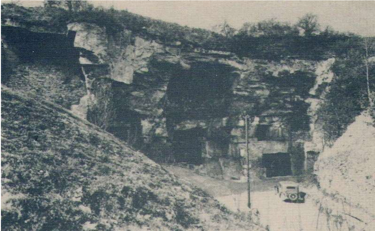
Entrée des carrières de Saint-Leu d'Esserent.
