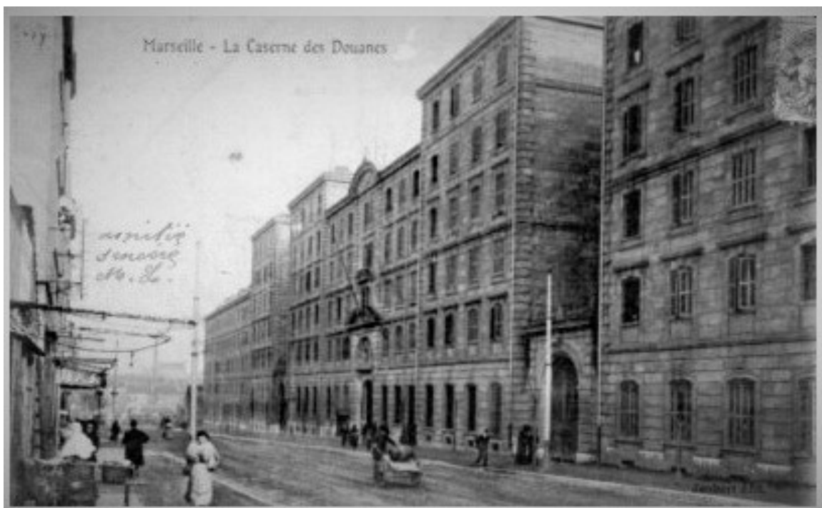
Caserne des Douanes de Marseille, inaugurée en 1903, dans le quartier de la Belle de Mai.
