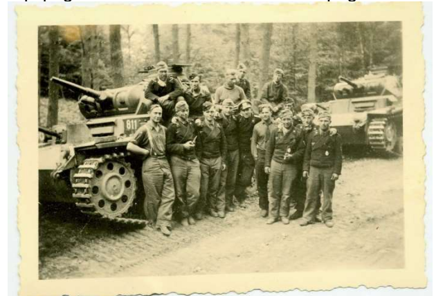
Ci-dessous une autre photo a été prise à Merville, entre Lillers et Hazebrouck.
