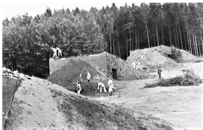
Mise en place du remblai autour de casemates de la série 500. Les batteries comprennent normalement quatre ouvrages de ce type. BAMA
