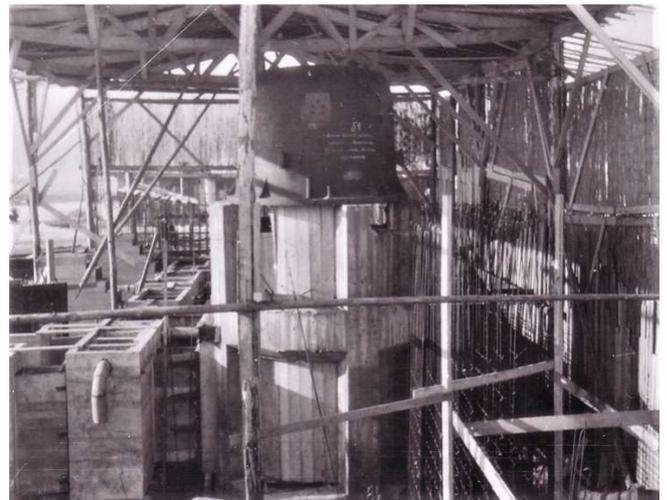
Cloche en place dans l'attente du bétonnage.
