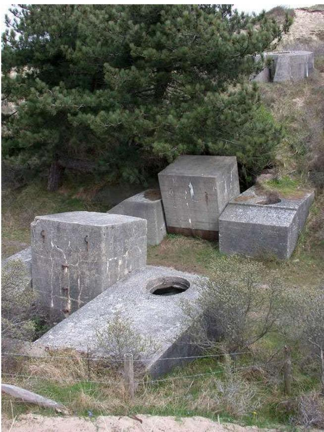
Autre système d'obstruction de route. Les blocs verticaux basculent sur leur base arrondie. Deux Tobrouks en protection. (photos K. Herbots)
