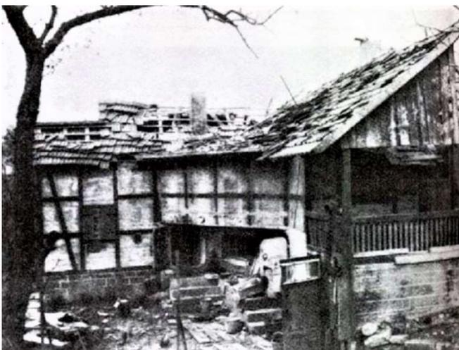
Très bel exemple de camouflage complet de l'ouvrage, murs et toit dissimulent l'entrée, au milieu de l'image, et le créneau de la caponnière à droite. (Photo A. Dietrich)
