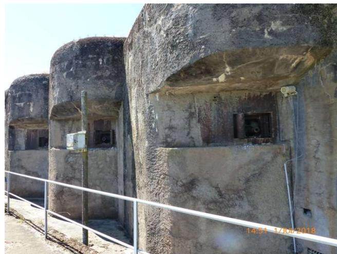
Bloc 4 de Fermont avec 3 canons de 75 (noter les volets blindés en position ouverte)
