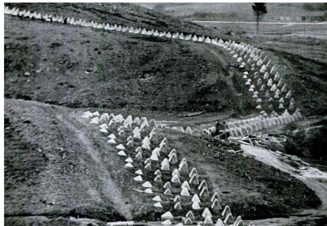
*Höckerlinie typ 38*, première version simple. Il n'y a que quatre blocs alignés.
