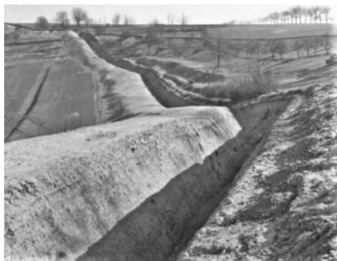
Fossé anti-char. Sa largeur doit être de 4,5 mètres et au moins deux mètres de profondeur afin de piéger le blindé. NARA
