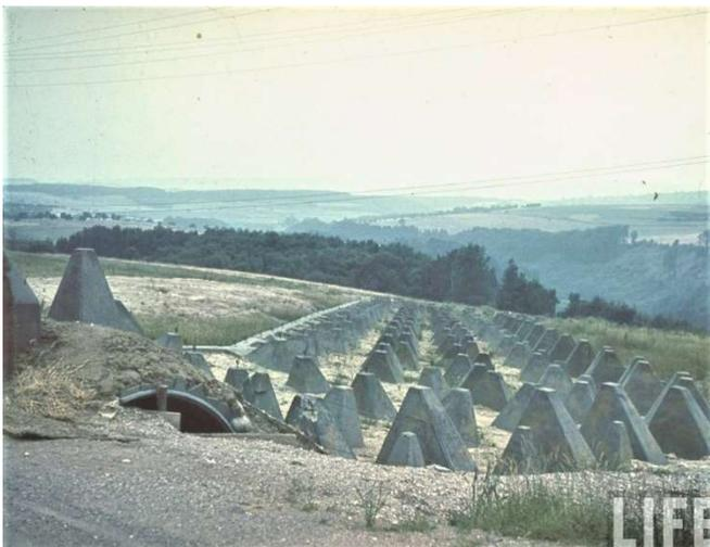
On peut apercevoir sur la gauche un abri simple en tôle métro. Il semble que les dents de dragons soient recouvertes avec un camouflage peint. LIFE
