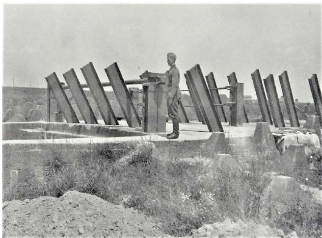
Obstacle routier avec poutrelles en acier de chaque côté de la route. On distingue aussi les barrières horizontales. BAMA
