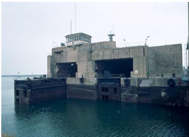
*L'abri pour les portes, coulissantes, de l'écluse Wattier est toujours en service. On voit les deux alvéoles de protection pour les portes. Une sécurité de plus au cas où l'une d'elles est hors service. Photo Pinterest.com*
