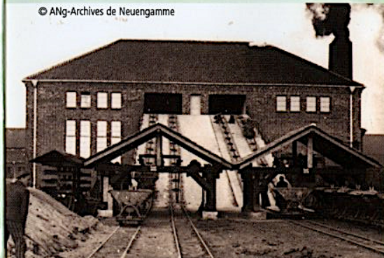
La briqueterie et sa rampe d'accès
